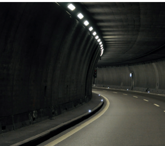
Tunel bez ochranné vrstvy
