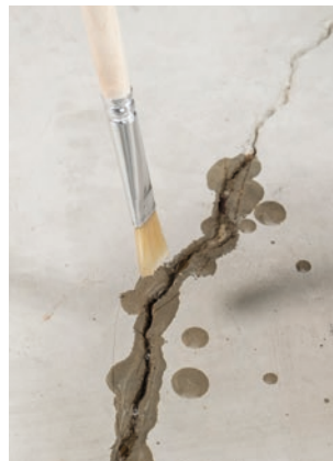
6. Aplikace pomocí štětce, špachtle atd. Trhlinu úplně vyplnit pryskyřicí.
