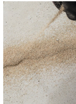
7. Trhlinu naplněnou pryskyřicí posypat křemičitým pískem. U širokých a hlubokých trhlin případně opakujte krok 6 a 7.
