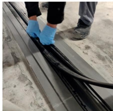
Einkleben des Dehnungsgummis in das Fugenprofil MC-Floor Connect CPS
