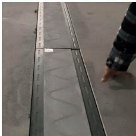
Einbau des Fugenprofils MC-Floor Connect CP
