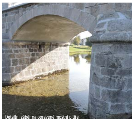
Detailní záběr na opravené mostní pilíře
