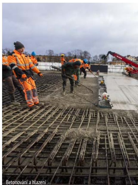
Betonování a hlazení
