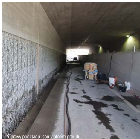
Přípravy podkladu jsou v plném proudu
