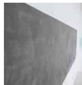
Krok 5: Konečná úprava povrchu se uskuteční s druhou vrstvou impregnace MC-Color Proof pure. Hotovo!
