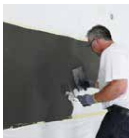
Krok 2: Aplikace první vrstvy stěrky Emcefix-Spachtel F lang, v antracitové barvě.
