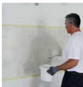
Krok 1: Oblepení a podle podkladu v případě potřeby nanesení penetrace.
