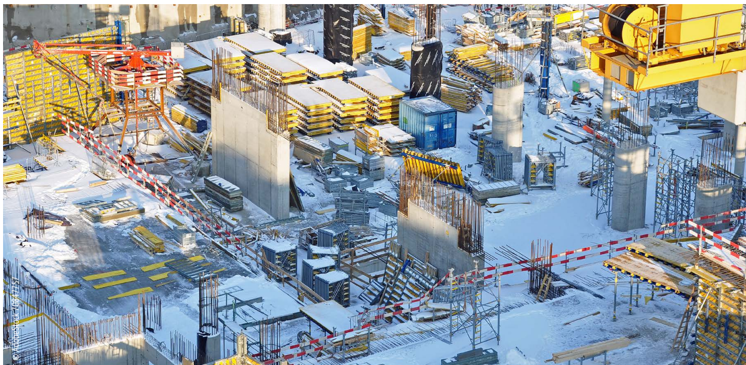
MC-FastKick nabízí také ve stavebnictví v zimním období mnoho výhod: vedle citelného ztekucení a rozšíření konzistence také velmi silný urychlující účinek a také rychlejší tvrdnutí než s konvenčními recepturami betonu.
