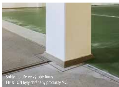
Polský výrobce potravin FRUCTON se rozhodl pro extrémně zatížitelnou průmyslovou podlahu MC-DUR PowerCoat 280 v zeleném provedení, která odolává teplotám do 120 °C.
